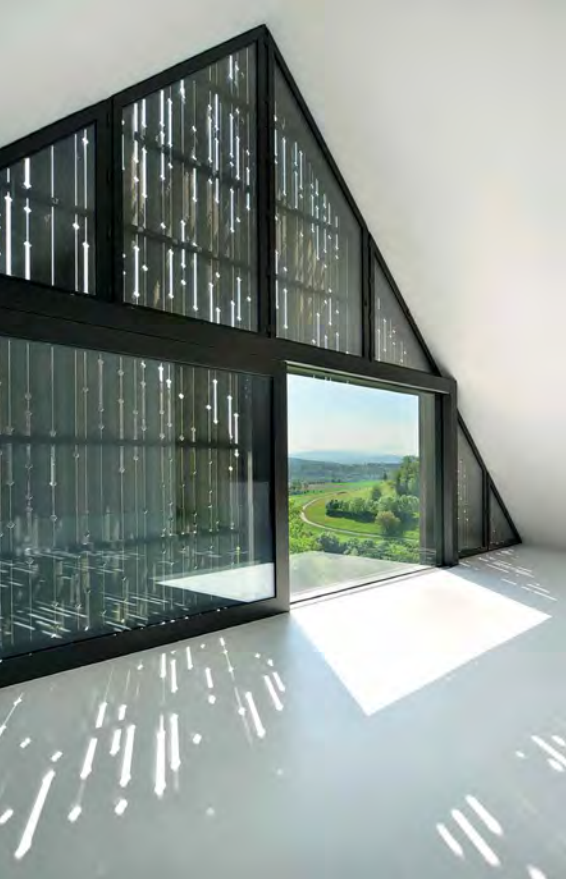
Abb. 14: Die unregelmäßigen Ausfräsungen in der Fassadenverkleidung erzeugen tagsüber im Innern...
