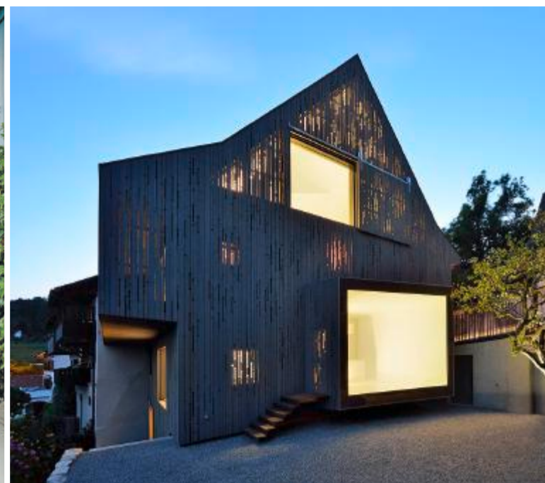
Anderthalb Fassadenseiten blieben übrig: Renoviertes Haus Lendenmann in Regensberg ZH (l.), Holzverschalung aus Fichten, rucksackartiger Balkon, moderner Innenausbau (u.)
