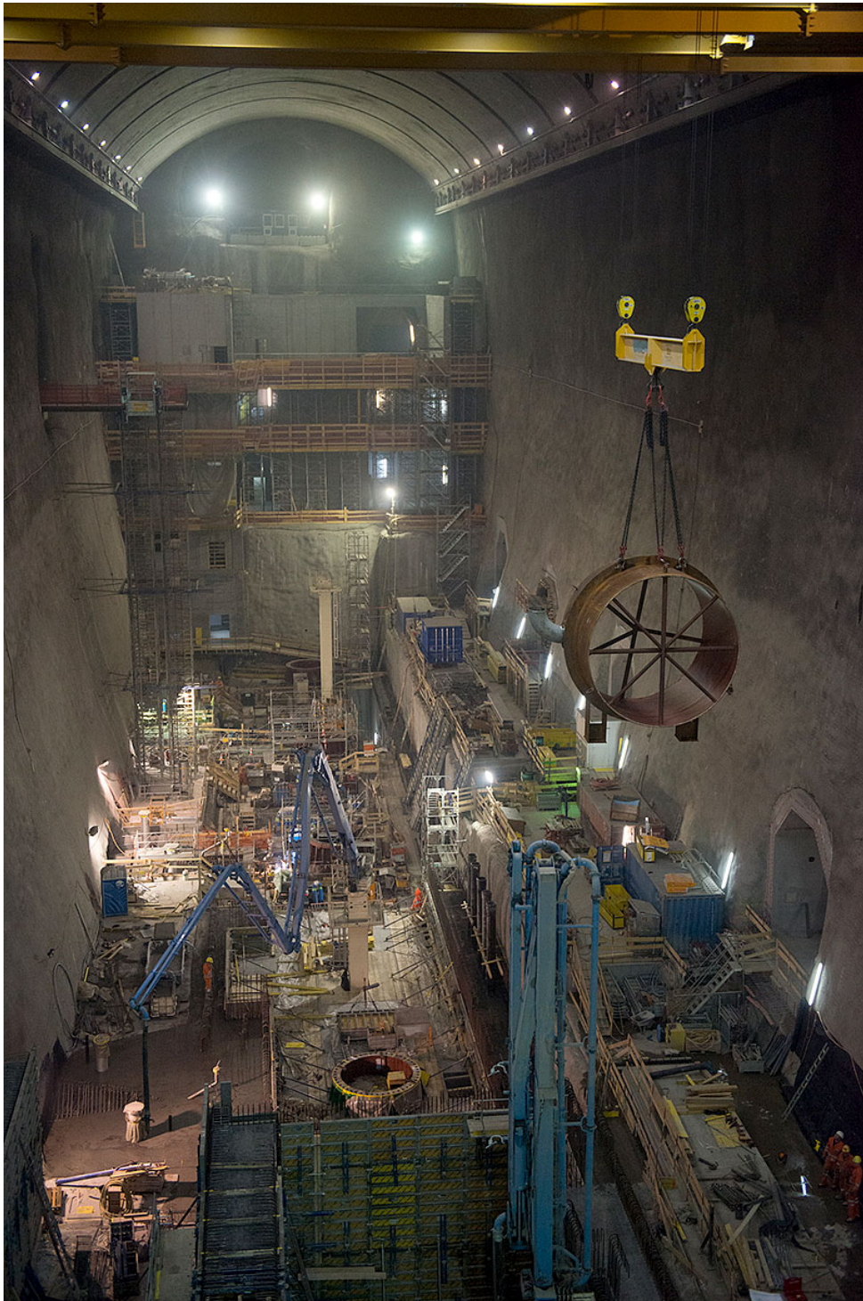
Abb. 8: Beginn der Betonarbeiten und Montage von Stahlwasserbauteilen (Foto: NDD)
