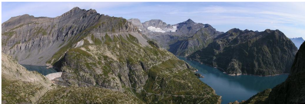
Abb. 1: Bestehende Stauseen Vieux Emosson (links) und Emosson (rechts)
