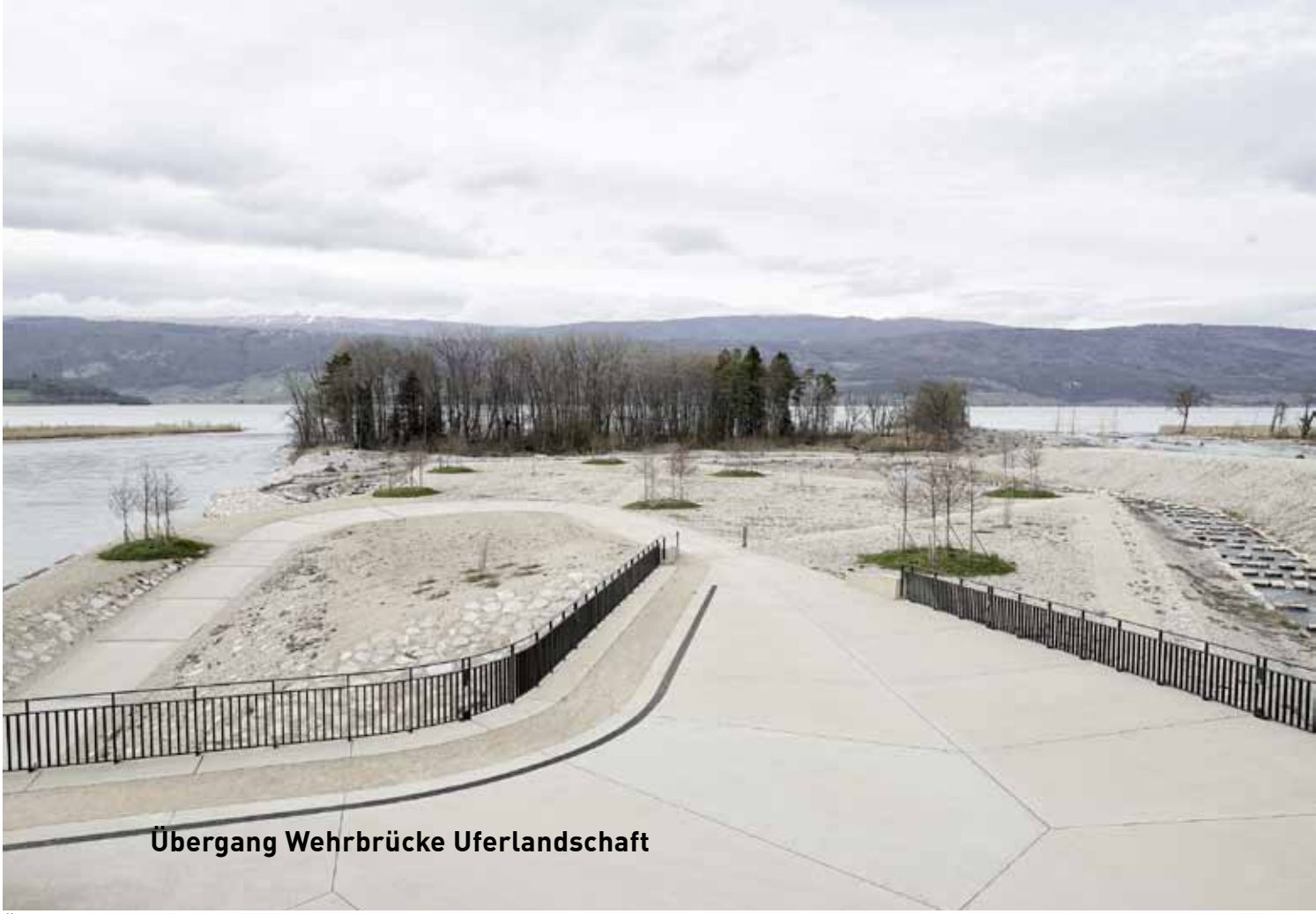
Übergang Wehrbrücke Uferlandschaft
