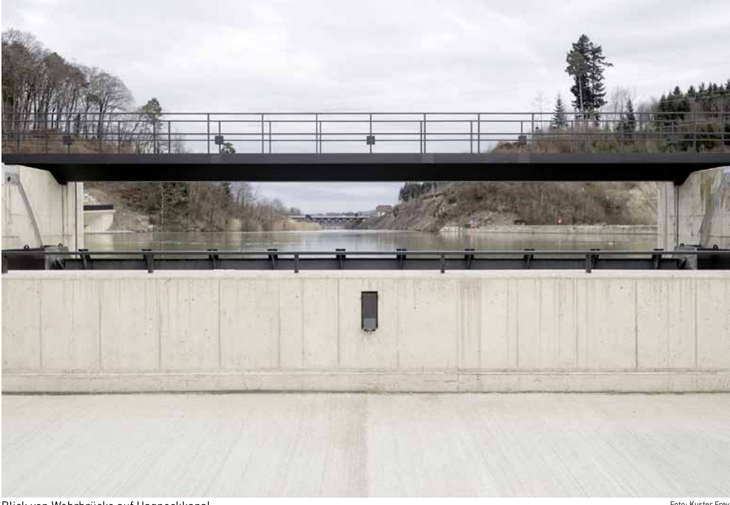
Blick von Wehrbrücke auf Hagneckkanal
