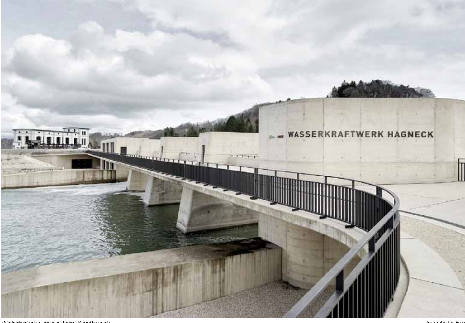
Wehrbrücke mit altem Kraftwerk
