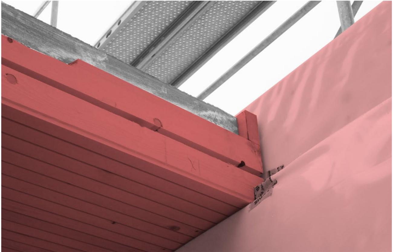
Abb. 91 Baustellenfoto vom Anschluss der Holz-Beton-Verbunddecke an die Fassade
