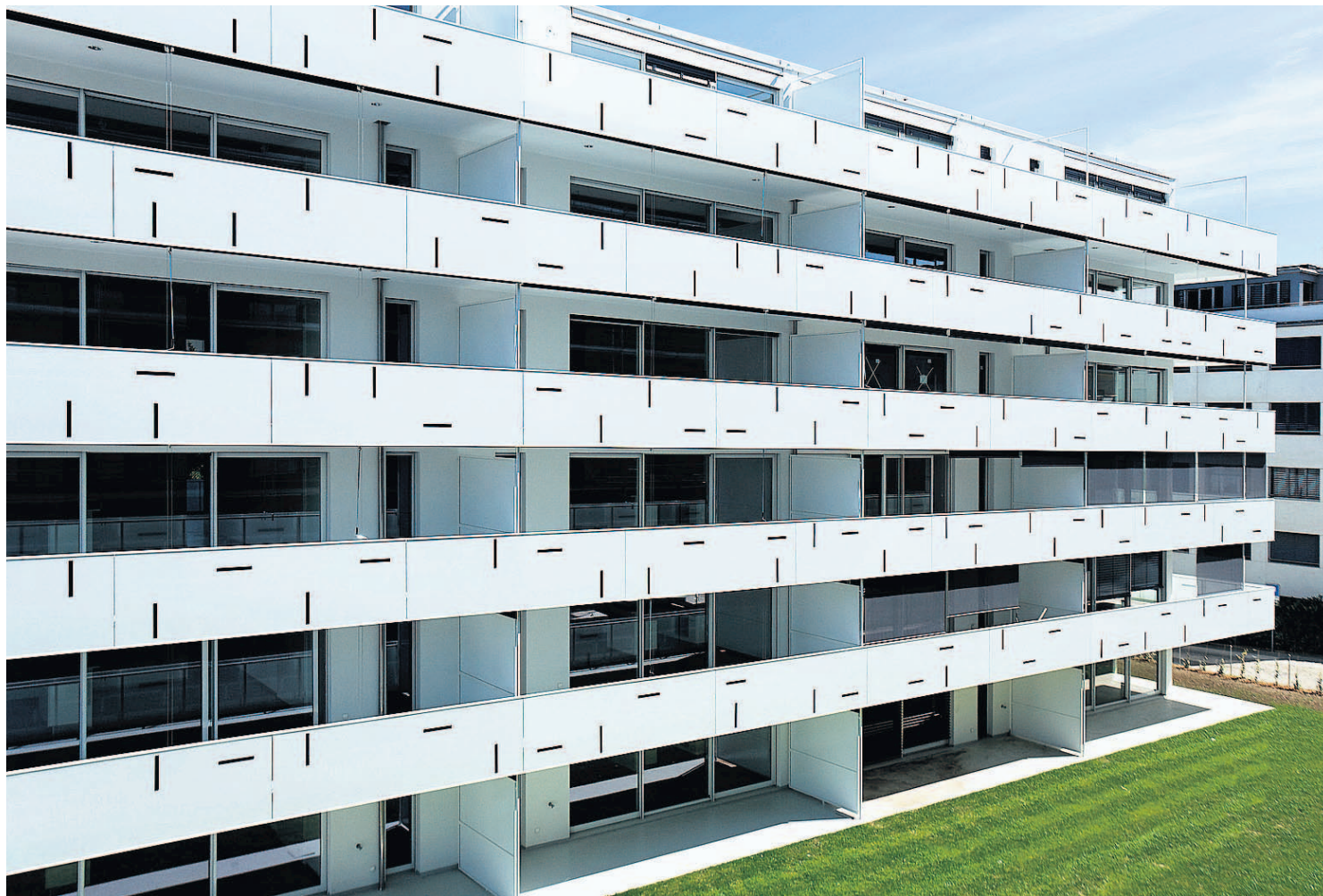
Klare Gliederung auf sechs Etagen: Im lang gezogenen Komplex sind 23 Apartments untergebracht
